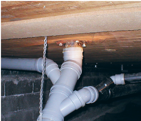
Exempel på grunder med stora otätheter i bjälklag/grundmur.
