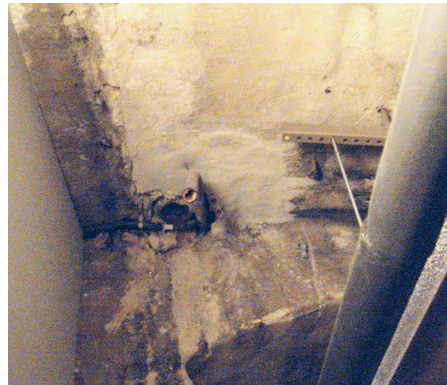
Exempel på grunder med stora otätheter i bjälklag/grundmur.
