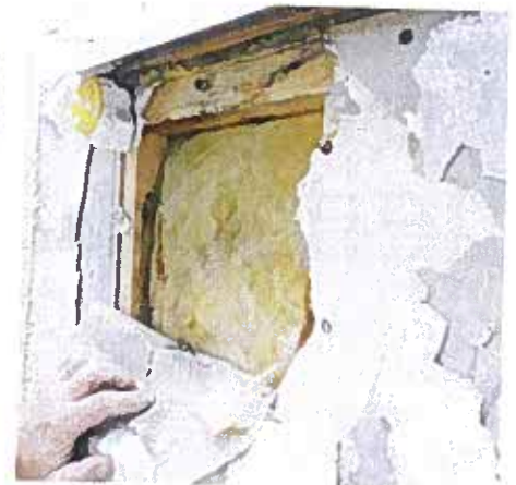
Mögelpåväxt på baksida av utvändigt gipsskiva samt regelverk under fönster.
