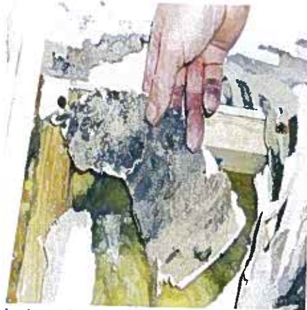
Större fukt- och mögelskada under fönster. Mögelpåväxt även på insidan av gipsskivan för "utomhusbruk".
