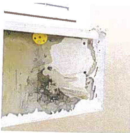
Större fukt- och mögelskada under fönster. Mögelpåväxt även på insidan av gipsskivan för "utomhusbruk".
