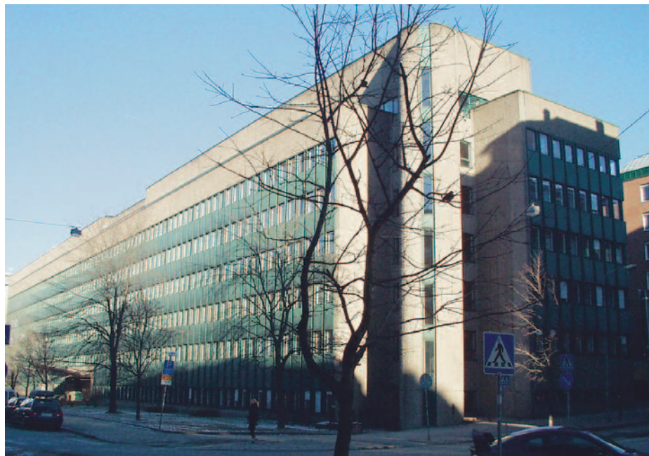
Byggnaden har två källarvåningar och sju kontorsvåningar.
