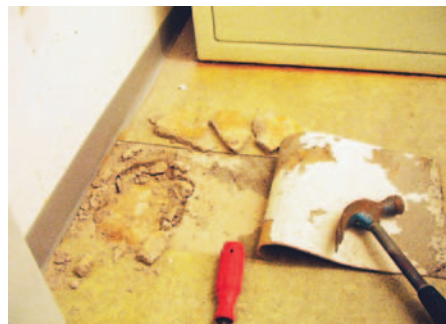
Mögellukt lokaliserades till möjlig sägsplan under överbetongen i plan 2.
