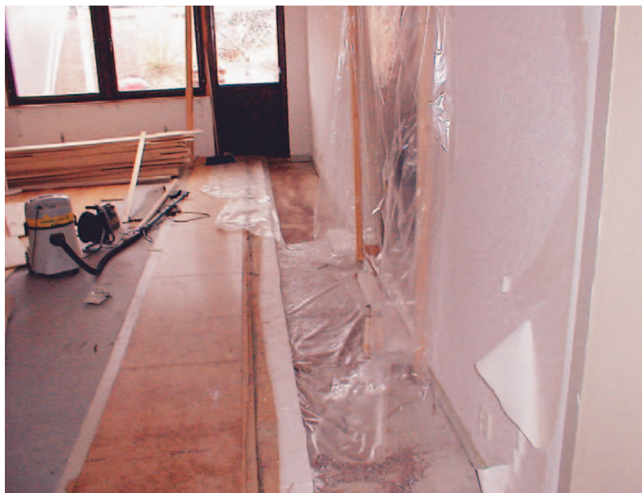
Åtgärder av golv och vägg i samband med fukrelaterad skada.
