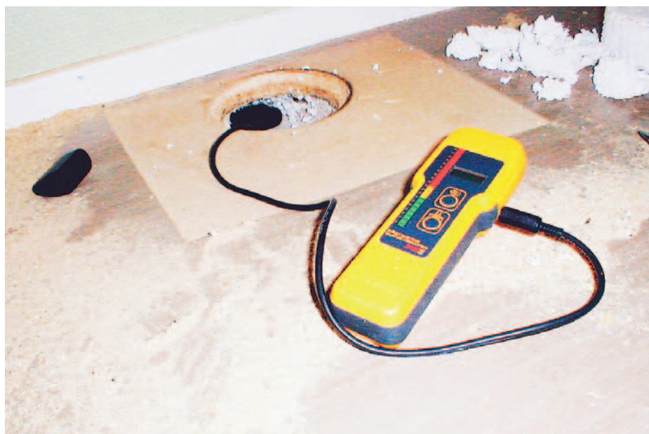
Fuktmätning i golvkonstruktion med fuktvotsmätare.
