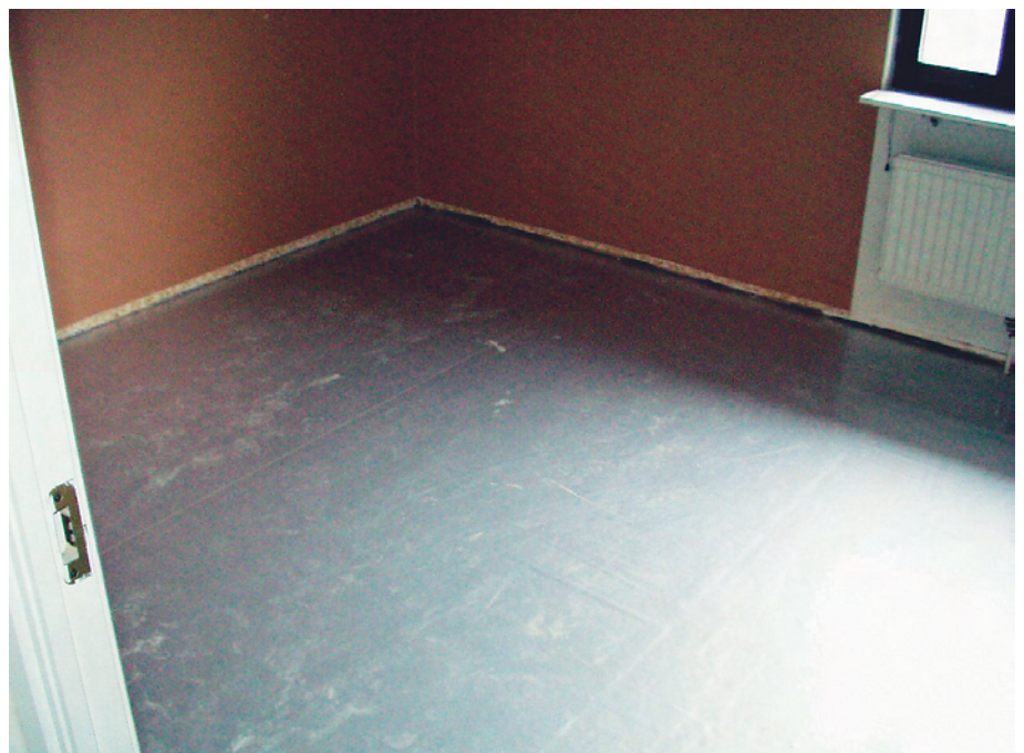
På den renslipade betongytan limmas aluminiumfolien.
