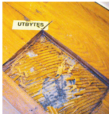
Limfilmen var inte heltäckande, vilket innebar att ekens undersida var fritt exponerad mot stor del av betongytan.
