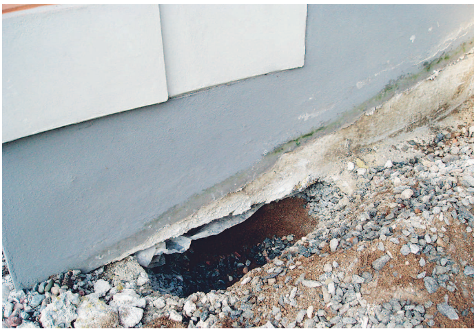
Bild 7: Omålad puts under mark har sugit in vatten. Vattnet som transporterats vidare kapillärt i putsen har sprängt bort färgen ovan mark.
