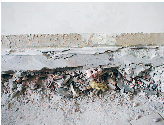
Fyllnadsbjälklag med mycket organiskt material inblandat.
