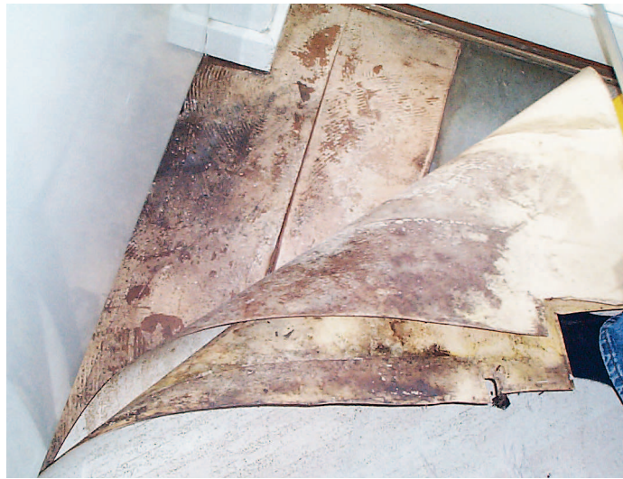
Dubbla mattor med mögelpåväxt mellan mattor.
